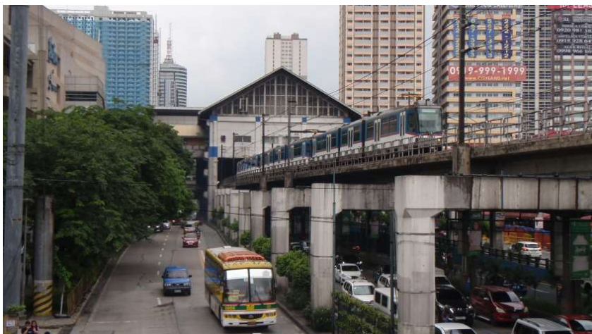
Shaw Boulevard駅 (MRT 3号線)
